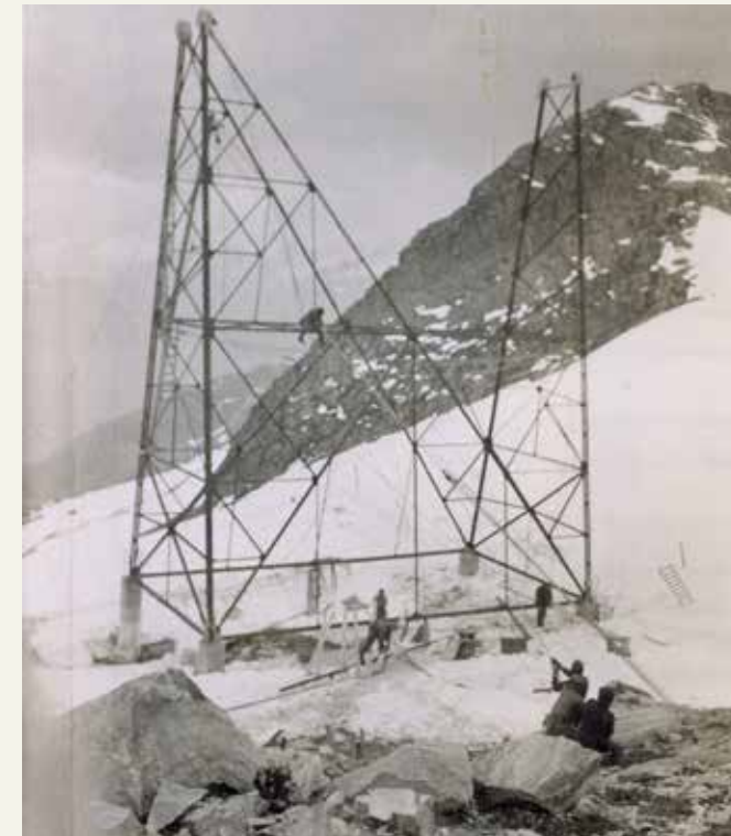
Bygging av mast. Tafjord kraftselskap.
