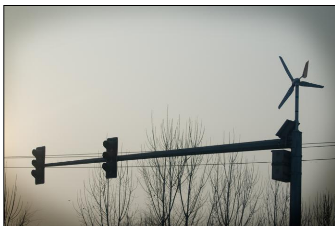
Bilde 10: Baoding bestreber seg også på å integrere fornybar energiløsninger i byplanleggingen, med bla bruk av solcellepaneler og små vindmøller til å forsyne strøm til trafikklys, offentlig belysning og sentral- and vannvarmeanlegg.
