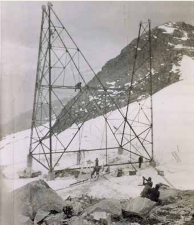
Bygging av mast. Tafjord kraftselskap.
