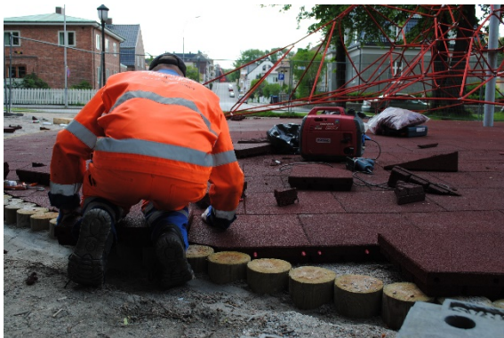
Eksempel på fallunderlag ved to av kommunens lekeplasser; gummimatte brukt i Domkirkeparken, støtsand på Mærrapanna.
